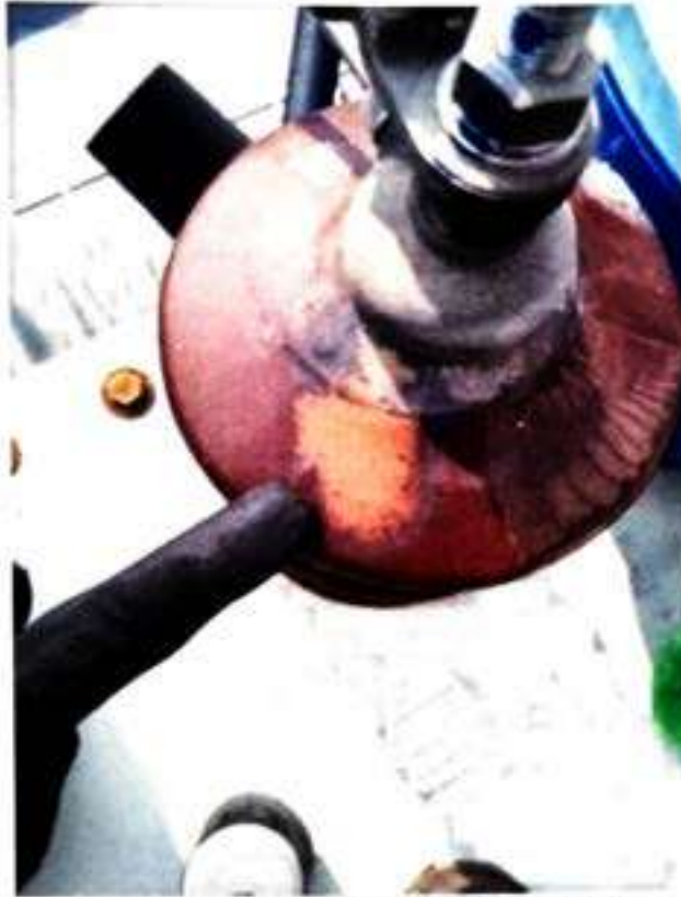
รูปที่ 1 ผิวฉนวนของบุชชิงแรงสูงเสื่อมสภาพ มีรอยของการเกิด Arc, Flash Over ที่ TR. 630 KVA (อาคาร A)
