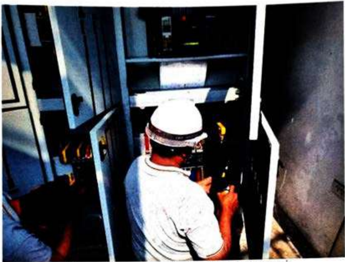
รูปที่ 7 ภาพการตรวจสอบและบำรุงรักษาตู้แผงสวิตช์ไฟฟ้าแรงต่ำ
