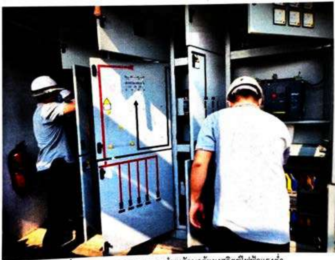
รูปที่ 7 ภาพการตรวจสอบและบำรุงรักษาตู้แผงสวิตช์ไฟฟ้าแรงต่ำ
