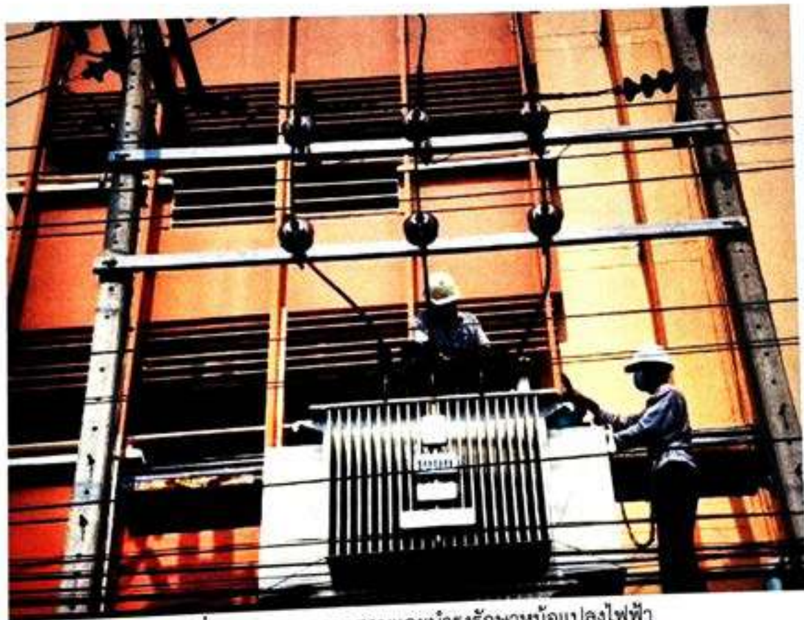
รูปที่ 5 ภาพการตรวจสอบและบำรุงรักษาหม้อแปลงไฟฟ้า
