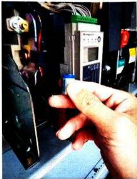
รูปที่ 3 เปลี่ยน Battery for Trip Unit ใหม่ ทดแทนของเดิมที่เสื่อม ที่ Main ACB อาคาร A และอาคาร B
