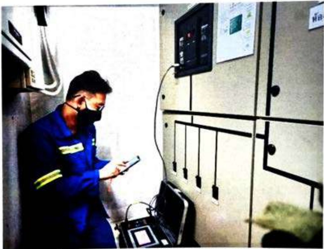
รูปที่ 10 ภาพการตรวจสอบและบำรุงรักษาตู้แผงสวิตช์ไฟฟ้าแรงต่ำ
