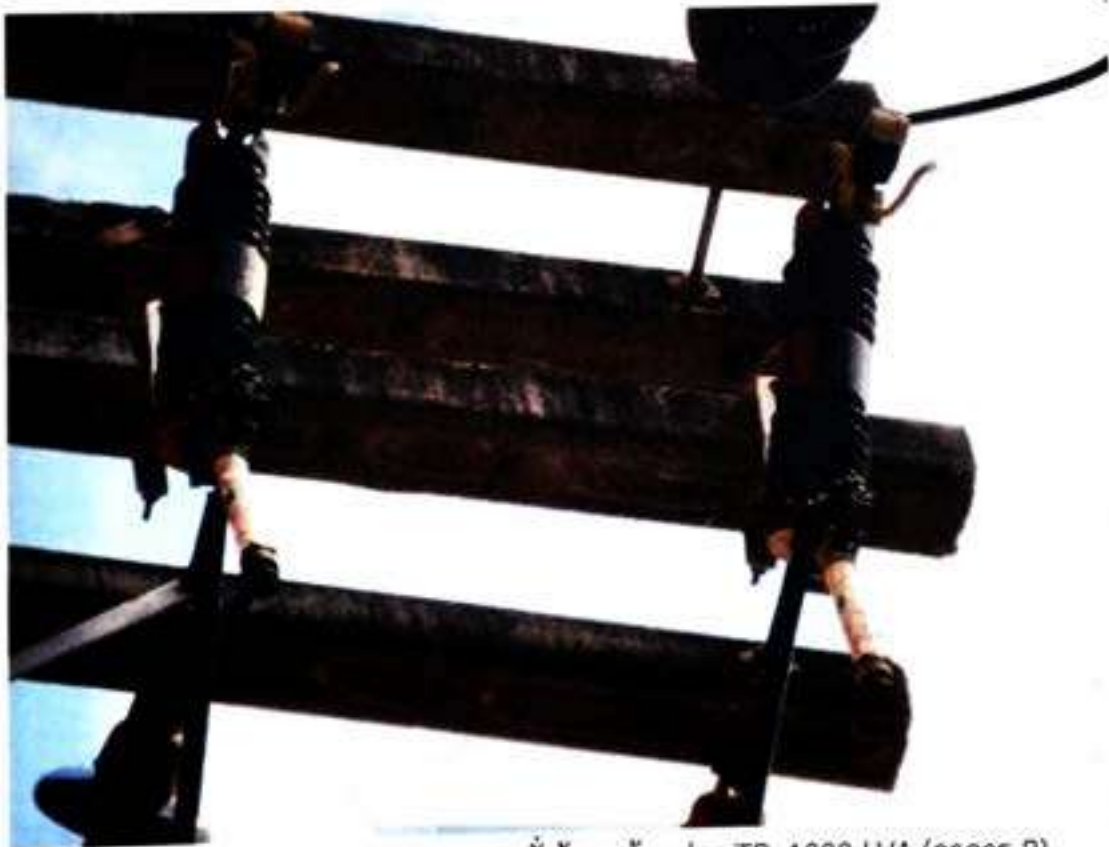
รูปที่ 1 ผิวฉนวนของบุชชิงแรงสูงเสื่อมสภาพ มีรอยของการเกิด Arc, Flash Over ที่ TR. 630 KVA (อาคาร A)
