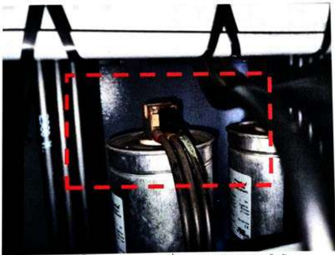
รูปที่ 4 ขั้วต่อสาย Terminator ที่ Capacitor Bank Step 1 ใหม่
