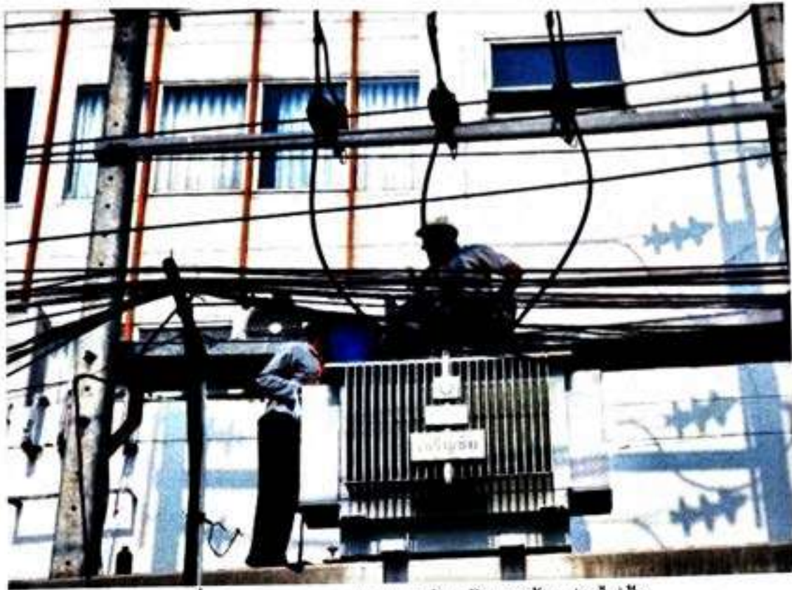
รูปที่ 5 ภาพการตรวจสอบและบำรุงรักษาหม้อแปลงไฟฟ้า
