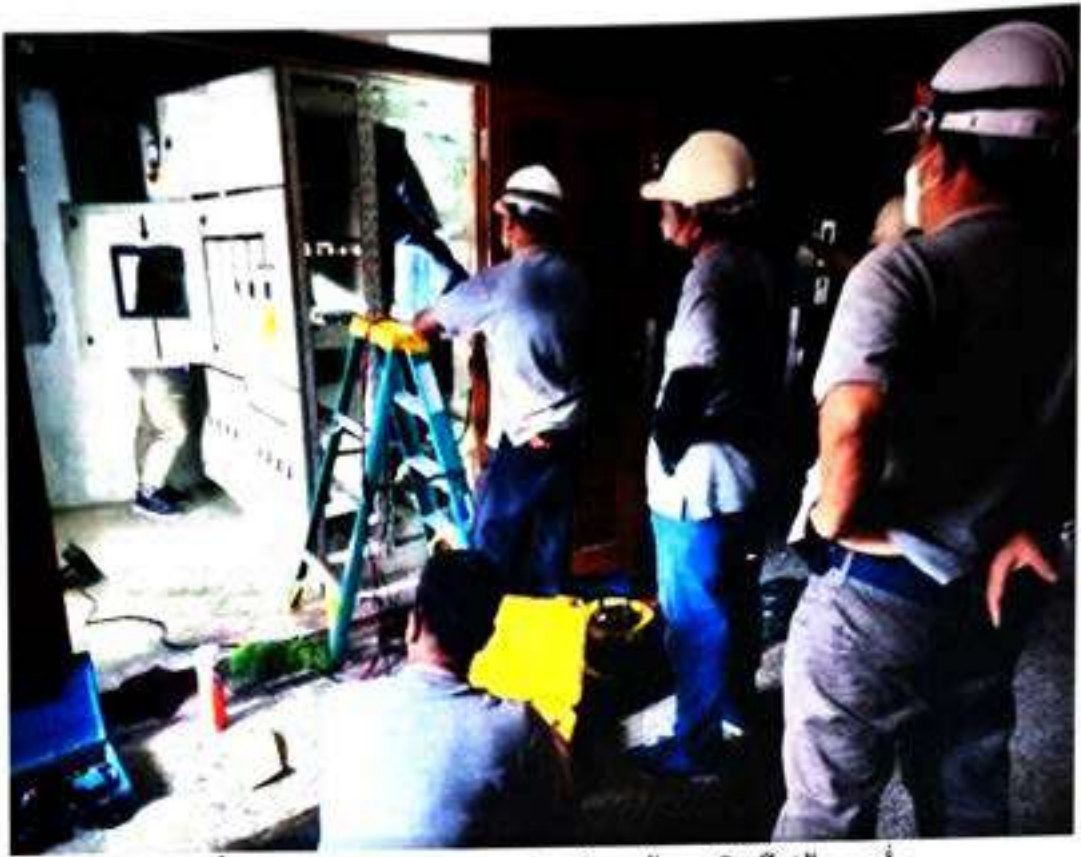
รูปที่ 9 ภาพการตรวจสอบและบำรุงรักษาตู้แผงสวิตช์ไฟฟ้าแรงต่ำ
